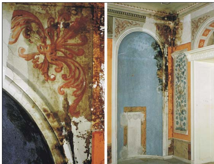
VII. Papierowe obicia ścienne, początek XIX w., częściowo zrekonstruowane w połowie XX w., Zamek Burgschlitz – Sala Ogrodowa, stan przed konserwacją (fot. J. Charytoniuk)
