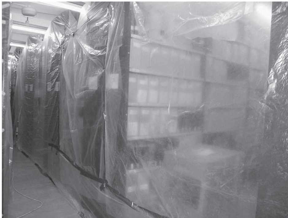
2. Zabezpieczenie materiałów archiwalnych w czasie remontu pomieszczeń, fot. E. Wikło
