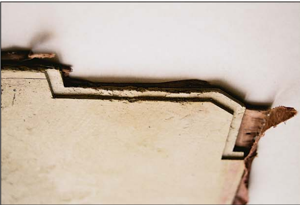
V. Okładka tylna z widocznym stopniem w tekturze do uzupełnienia. Widoczne partie tektury o obniżonej wytrzymałości mechanicznej utrudniające wycięcie stopnia (fot. B. F. Zerek)
