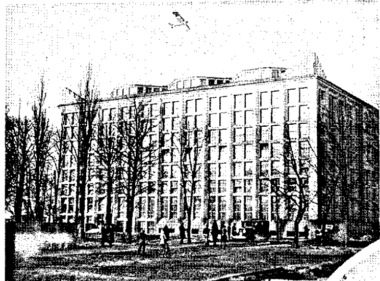
Tymczasowe pomieszczenie Biblioteki Narodowej. Wielki gmach Wyższej Szkoły Handlowej w Warszawie, gdzie Biblioteka Narodowa narazie znalazła siedzibę.
